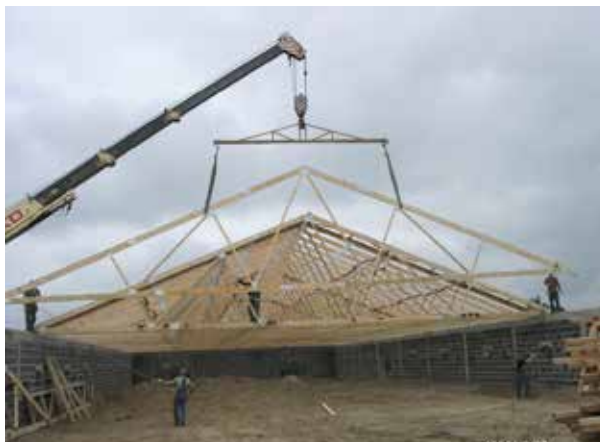
MiTek tetőszerkezet építése
